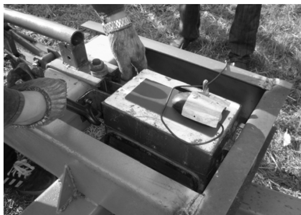
Рис. 6. Монтаж измерительного датчика
