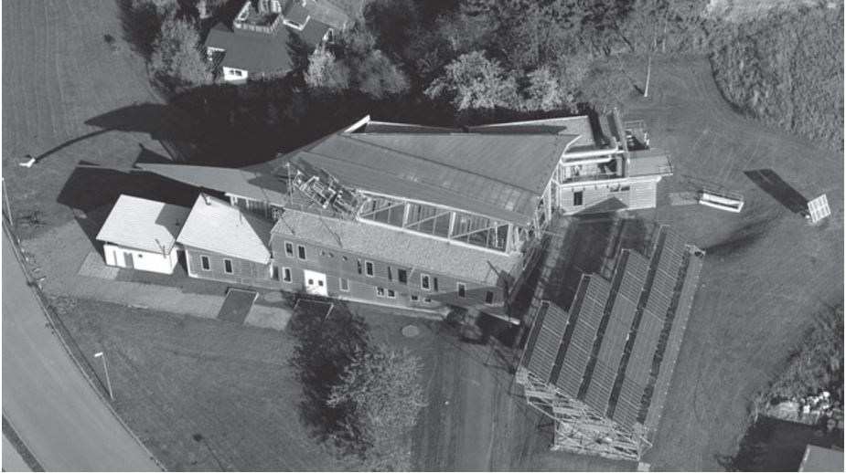
Figure 7.1: HySolar building in Stuttgart (DLR – Deutsches Zentrum für Luft- und Raumfahrt).
