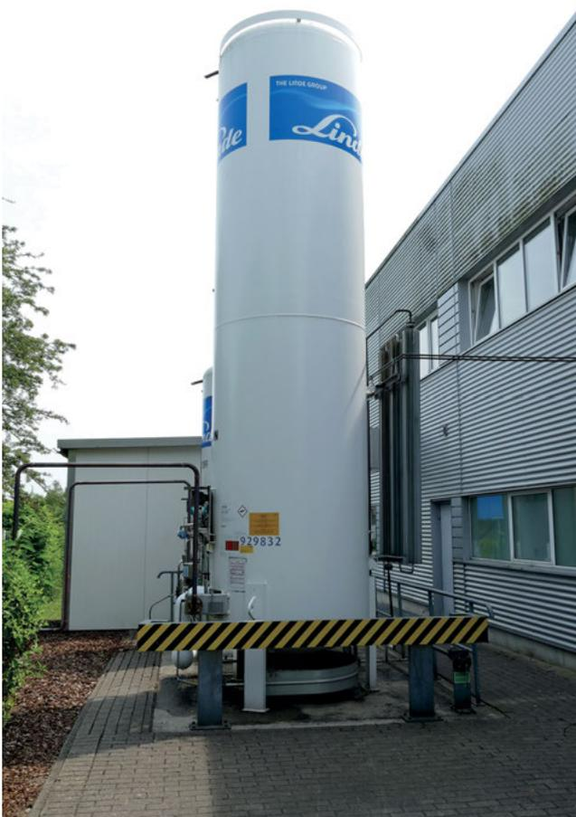
**Abb. 3.37:** Tank für Flüssiges Argon, Abdruck mit freundlicher Genehmigung der Firma SPECTRO Analytical Instruments GmbH, Boschstr. 10, 47533 Kleve
