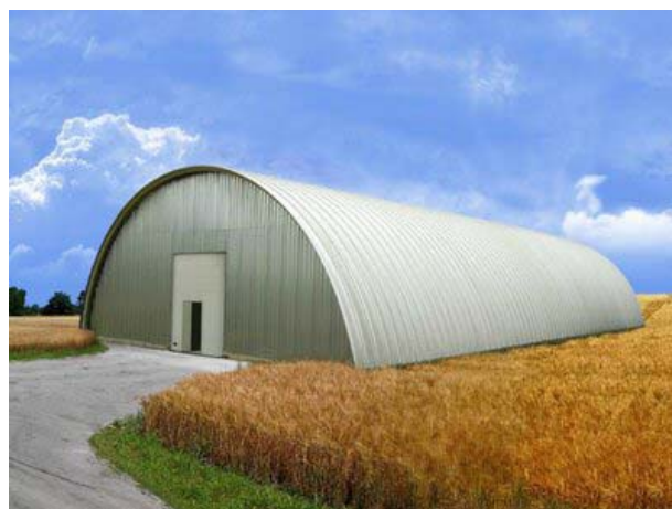
Рис. 3. Ангар для зерна металлический бескаркасный
