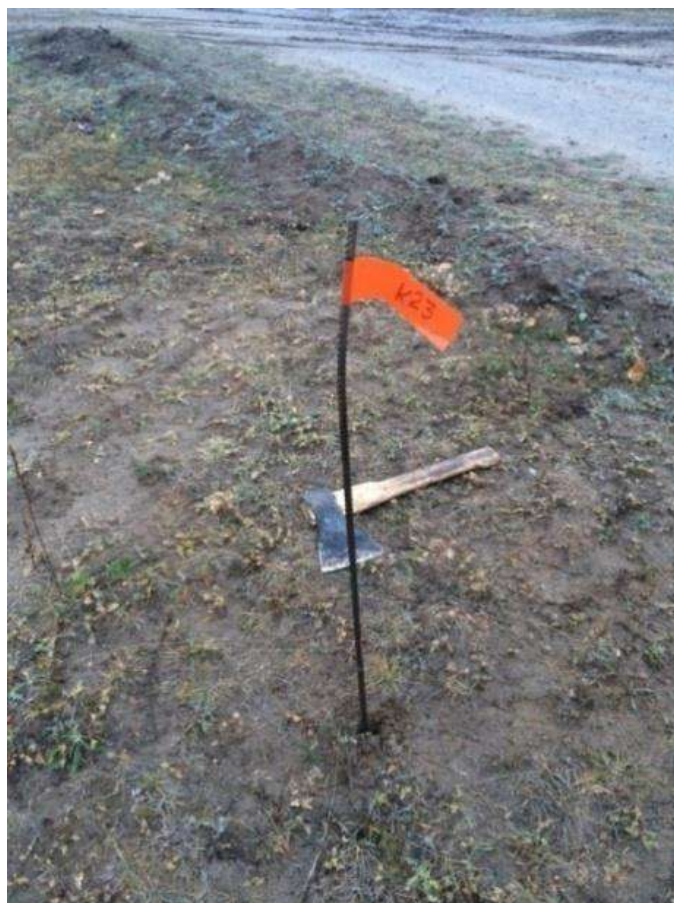
Рис. 1. Разметка трассы металлическими штырями
